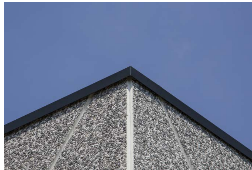
Immagine 14 Fotografia pannello prefabbricato Particolare cappello in lamiera preverniciata
