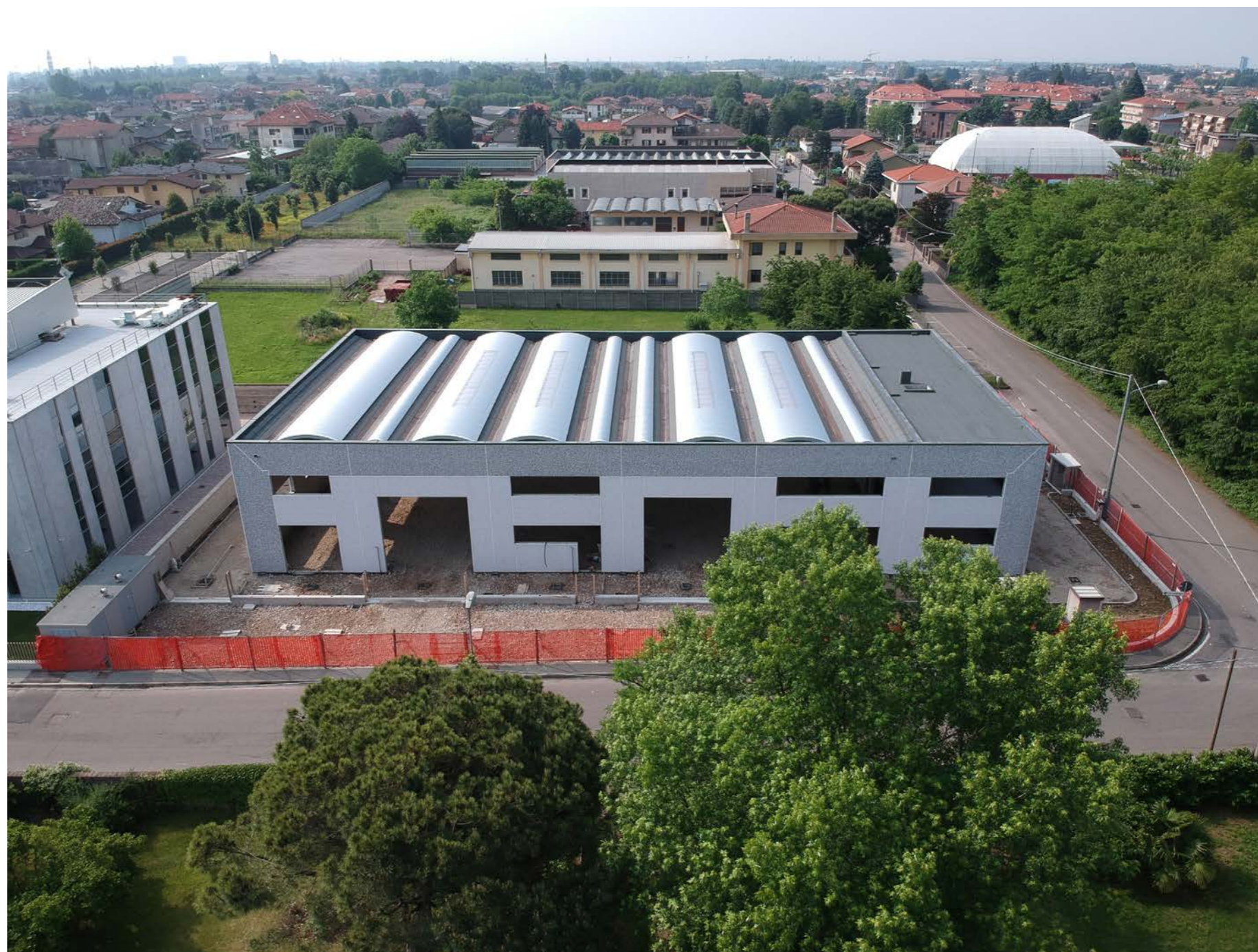
Immagine 34 Fotografia cantiere Vista aerea fronte nord, via Ombrone
