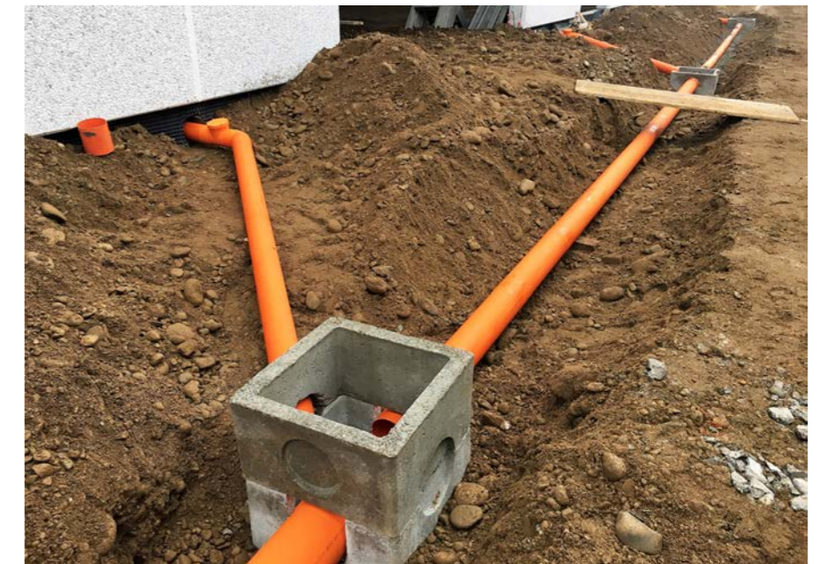
Immagine 28 Fotografia rete di raccolta acque meteoriche Particolare caditoia piazzale esterno
