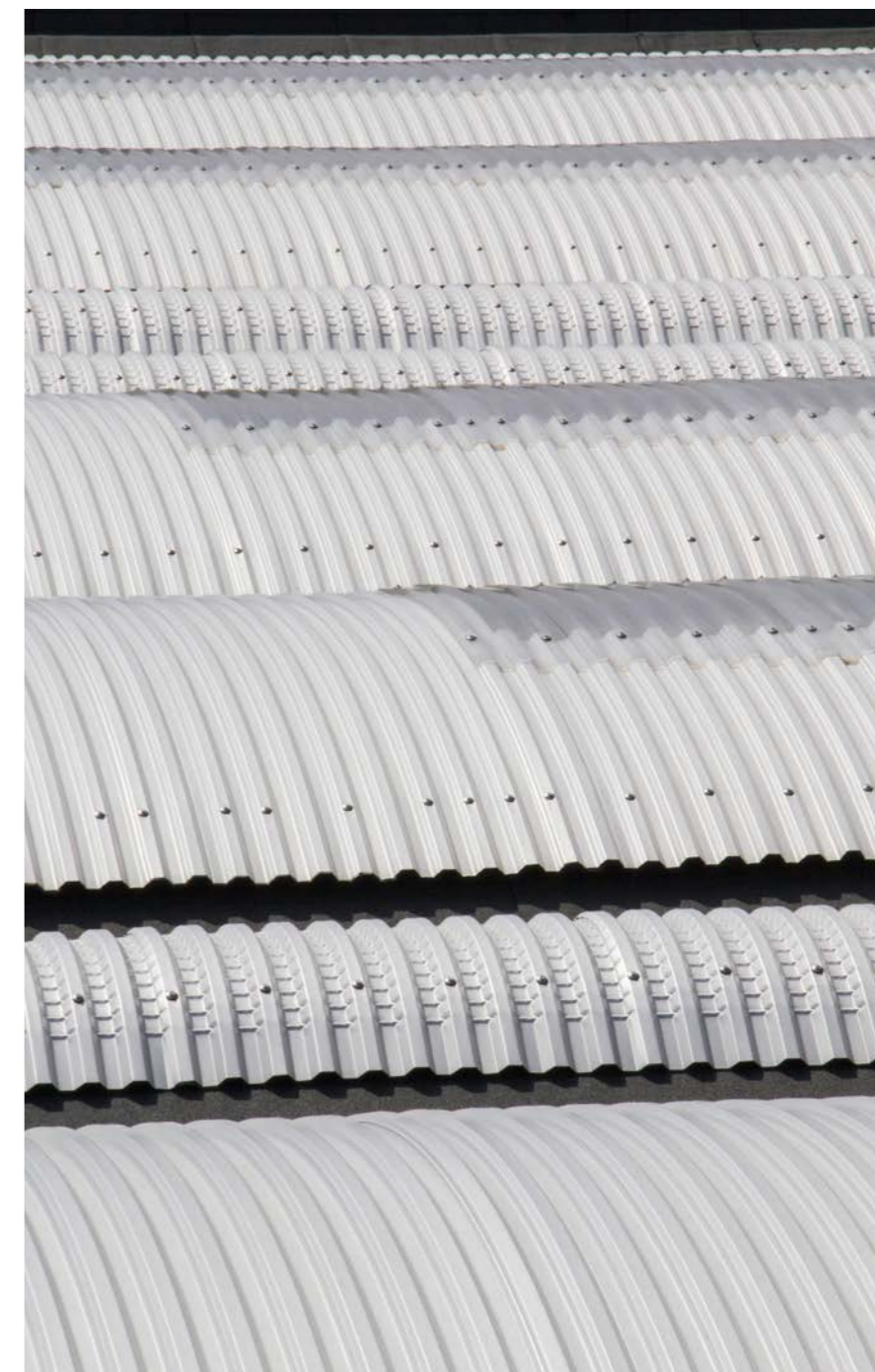
Immagine 15 Fotografia copertura zona produttiva Particolare copertura in tegole e coppelle prefabbricati
