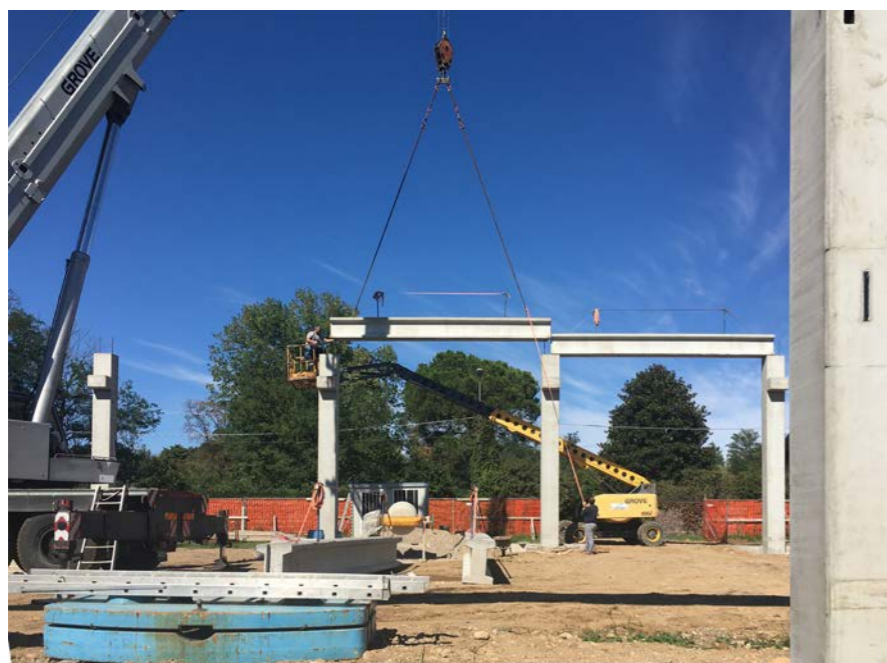
Immagine 12 Fotografia montaggio struttura prefabbricata Particolare posa travi piane in c.a.p. a doppio T
