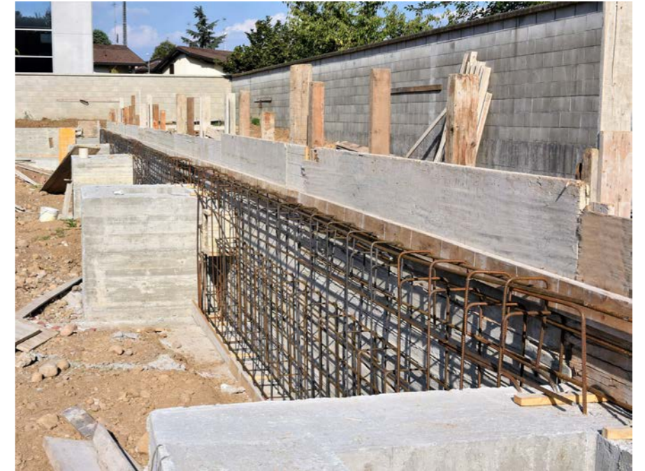
Immagine 9 Fotografia fondazioni Particolare armatura trave portapannello
