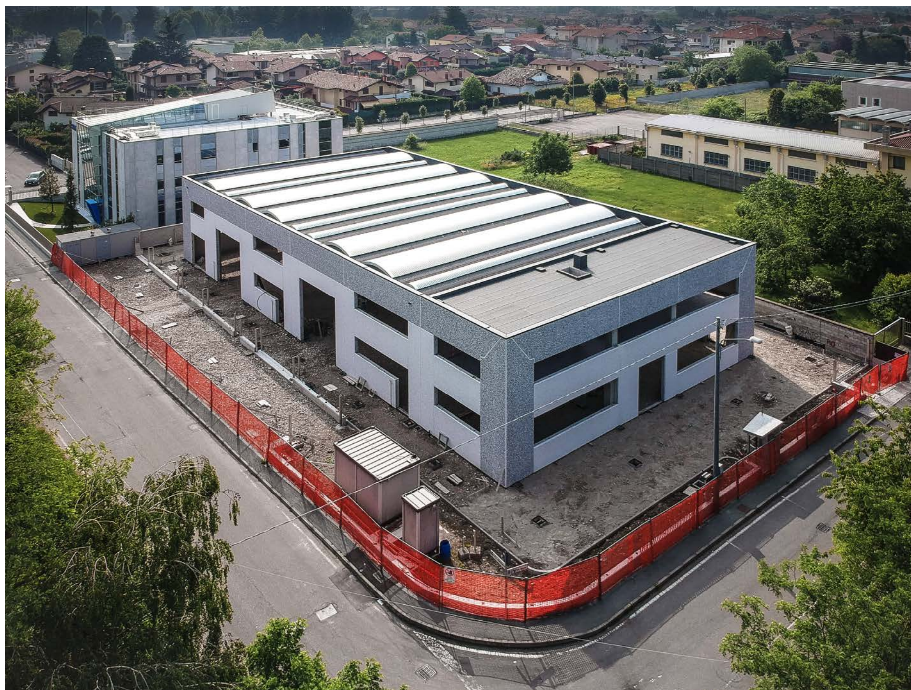
Immagine 3 Fotografia cantiere Vista aerea nord-ovest, via Ombrone angolo via Serio
