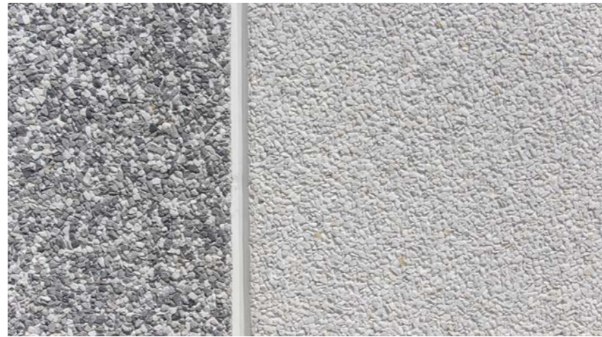
Immagine 17 Fotografia pannello prefabbricato Particolare finitura esterna a graniglia lavata
