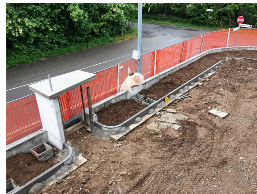
Immagine 33 Fotografia cantiere Particolare accesso pedonale via Ombrone
