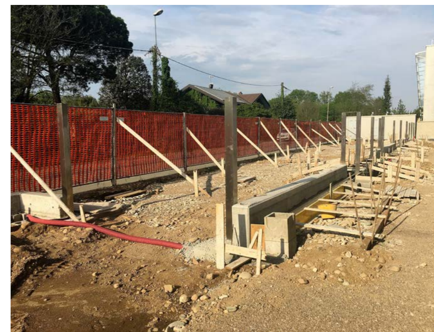
Immagine 32 Fotografia cantiere Particolare piantane acciaio inox cancelli via Ombrone
