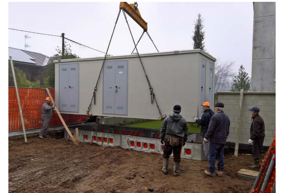
Immagine 30 Fotografia cantiere Fase di posa cabina ENEL prefabbricata
